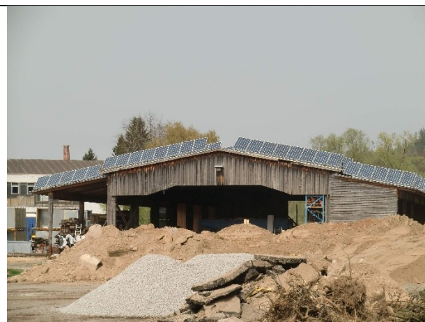
Abbildung 3: Halle im Nordosten
