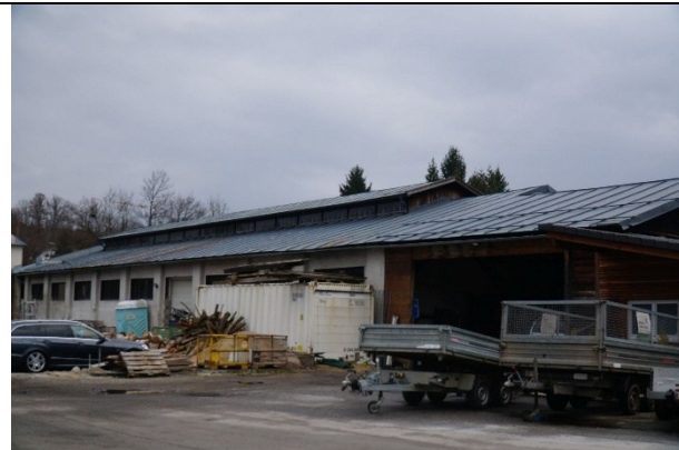
Abbildung 1: Hallen-, Garagen-, Verwaltungsgebäude, Lagerräume im Süden
