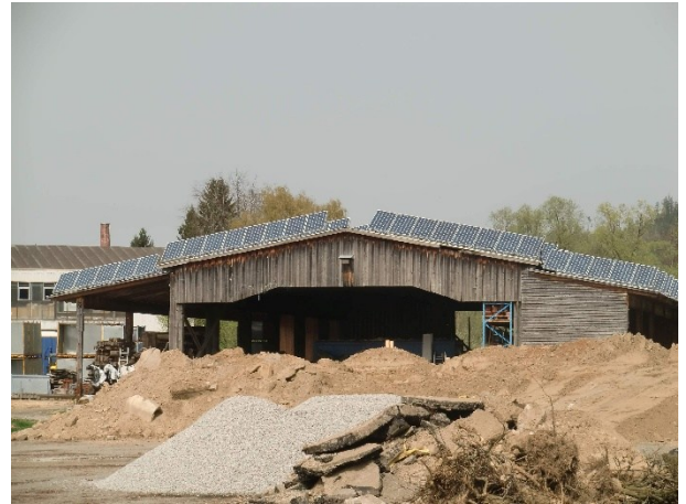
Abbildung 13: Lagerhalle im Nordosten
