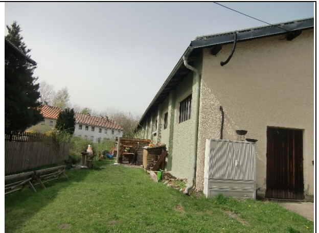
Abbildung 2: Gebäude im Süden
