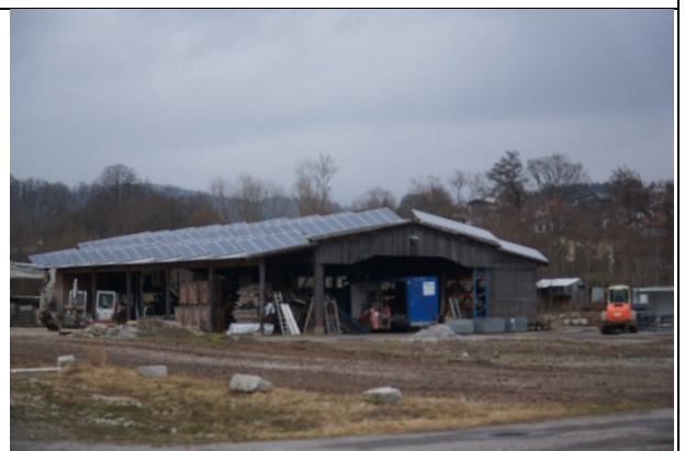
Abbildung 4: Halle im Nordosten
