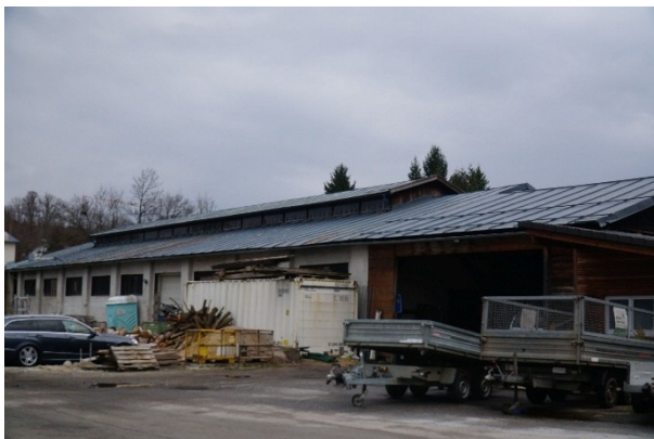
Abbildung 14: Gebäudekomplex im Süden
