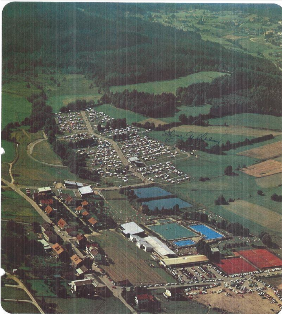
Schrägluftbild aus der Bauphase, ca. 1971
