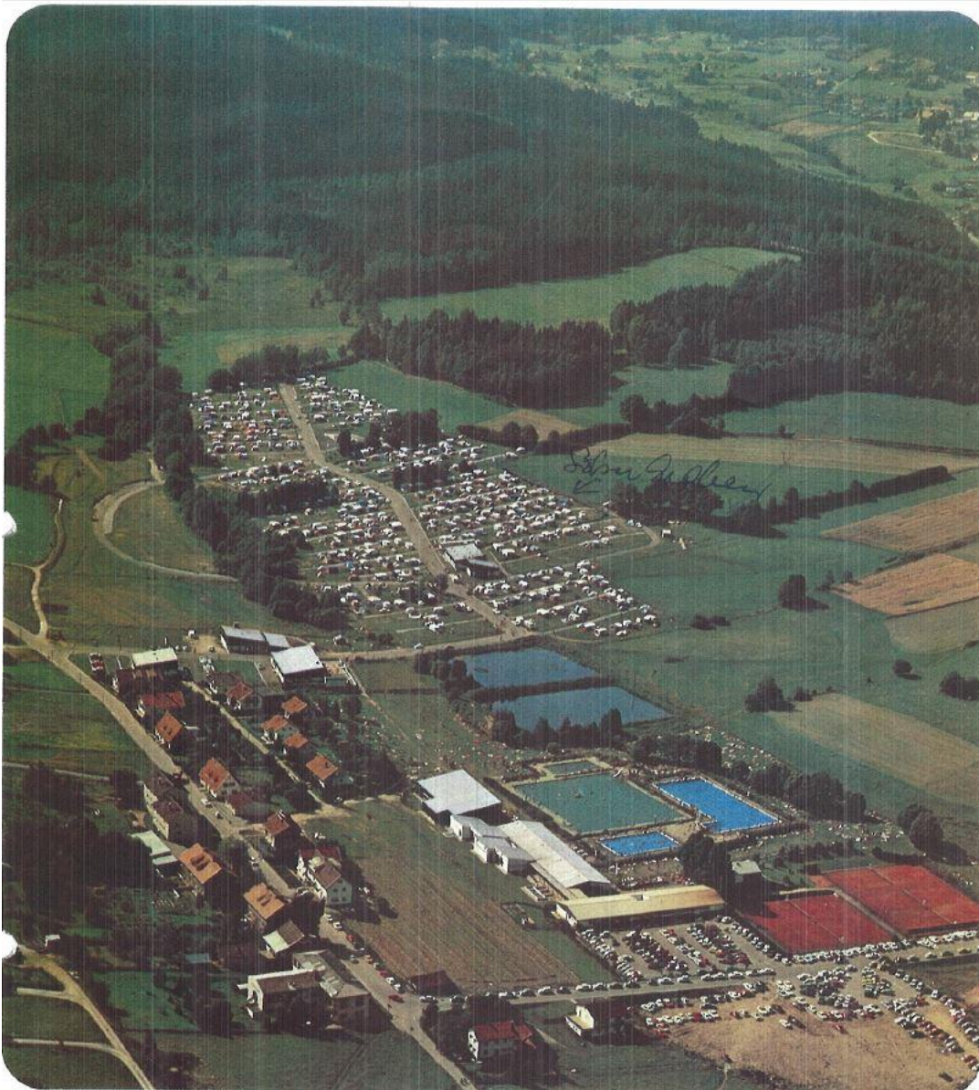
Schrägluftbild aus der Bauphase, ca. 1971
