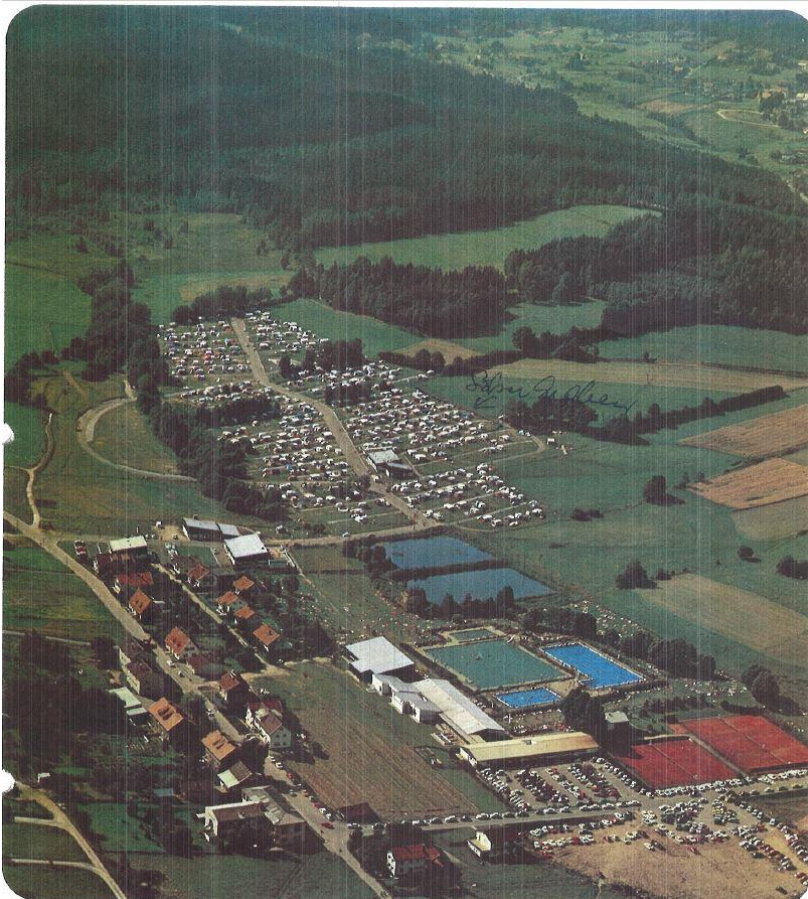
Schrägluftbild aus der Bauphase, ca. 1971
